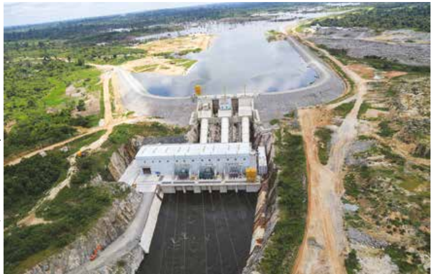
Le barrage de Soubré fonctionnel depuis le 2 novembre 2017. (Photo DR)
