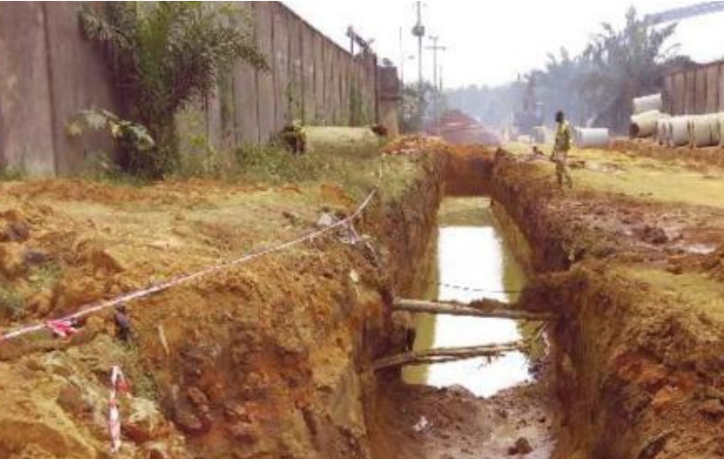
Conduite d'eau potable à déplacer (Photos : DR)
