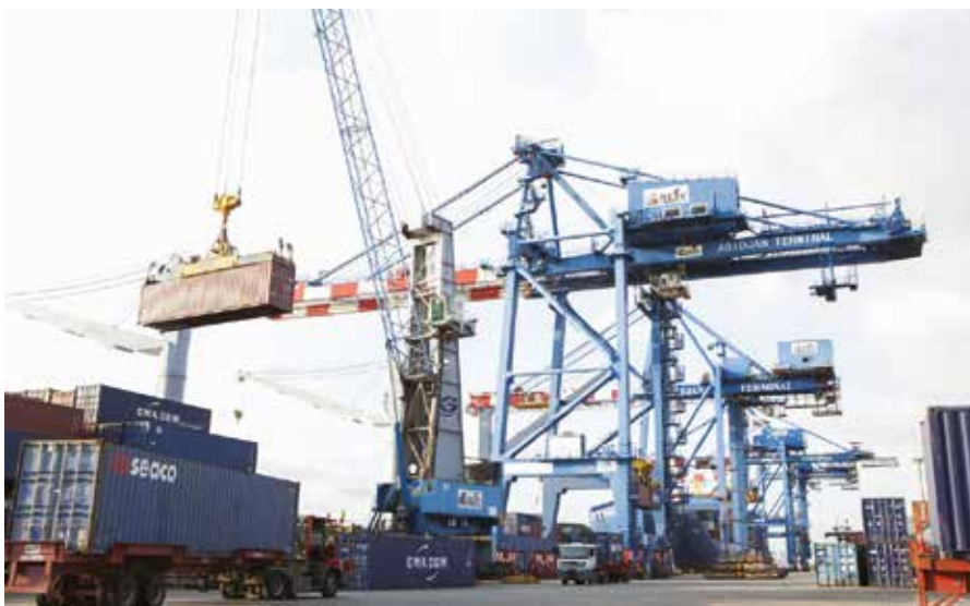
Manutention de conteneurs par une grue au Port Autonome d'Abidjan (Photos DR)
