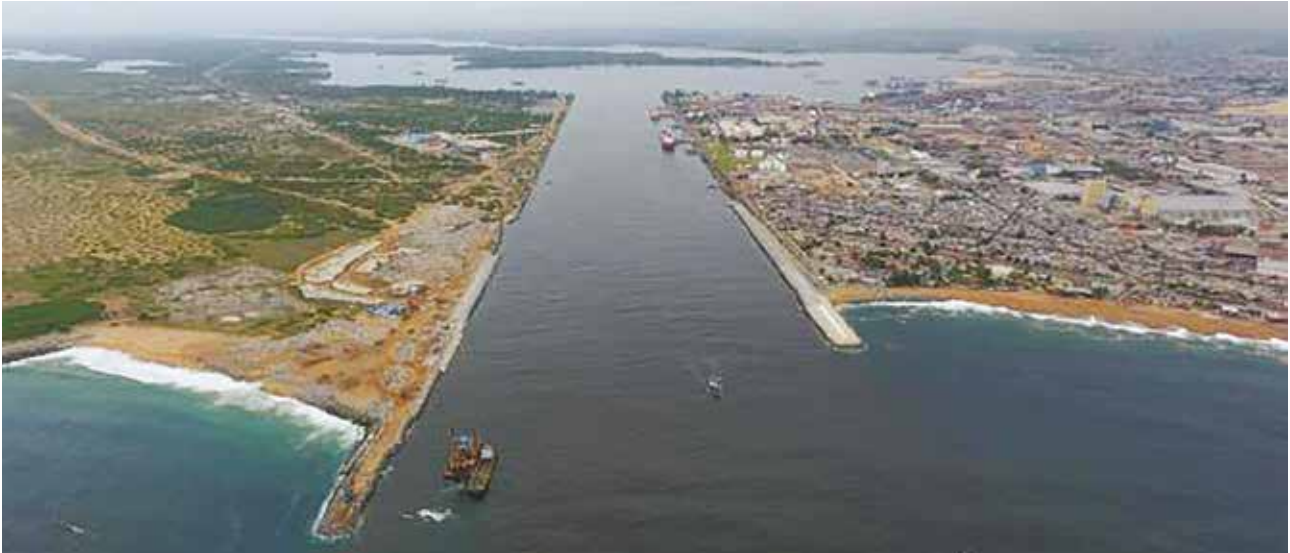
Travaux d'élargissement-Approfondissement du canal de Vridi.
