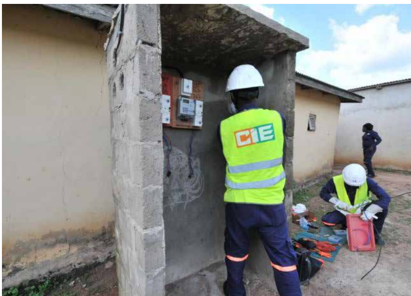
Des techniciens de la CIE procèdent à un branchement dans un village (Photo DR)
